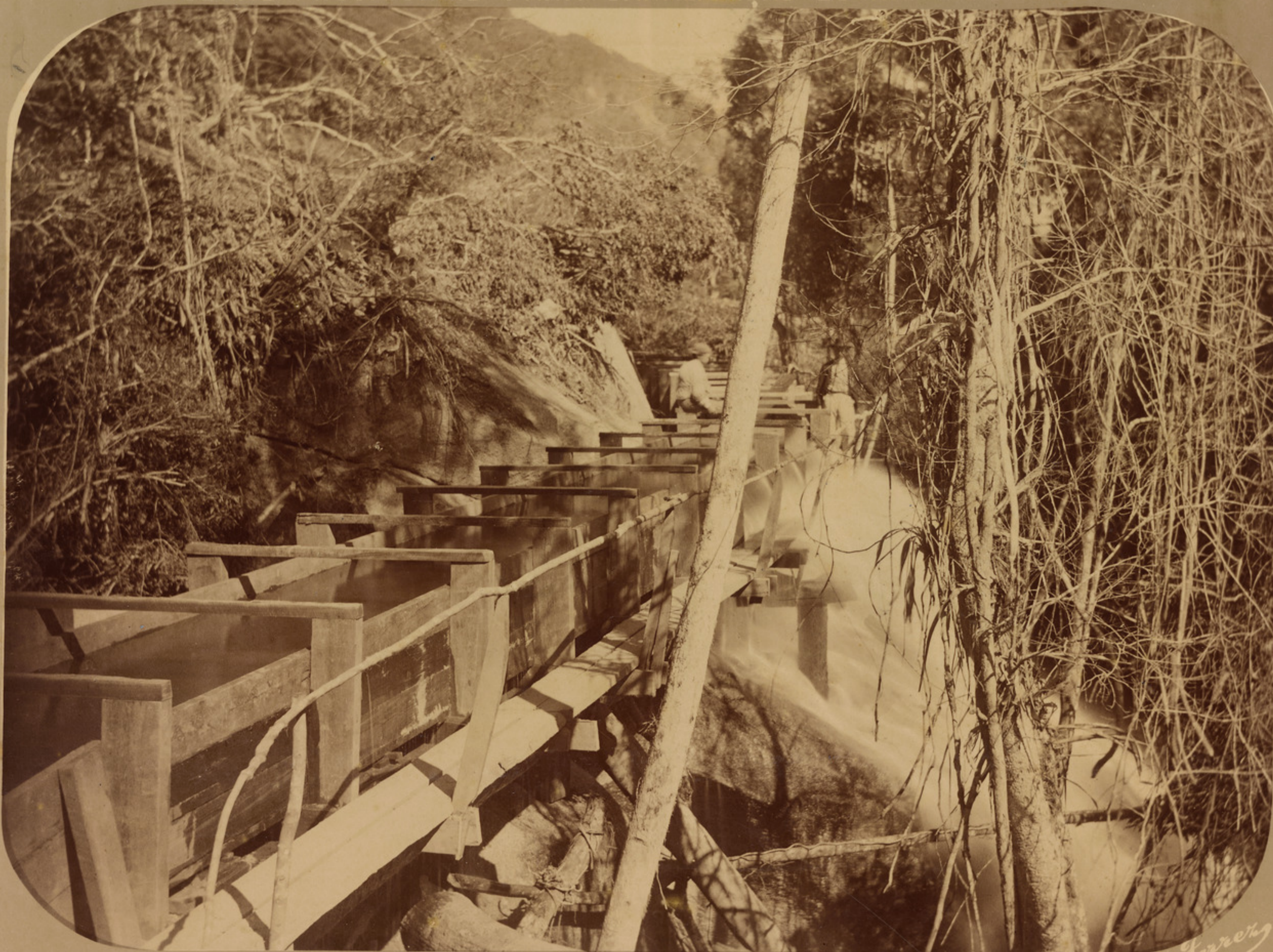
Aqueducto do Arsenal K.4
