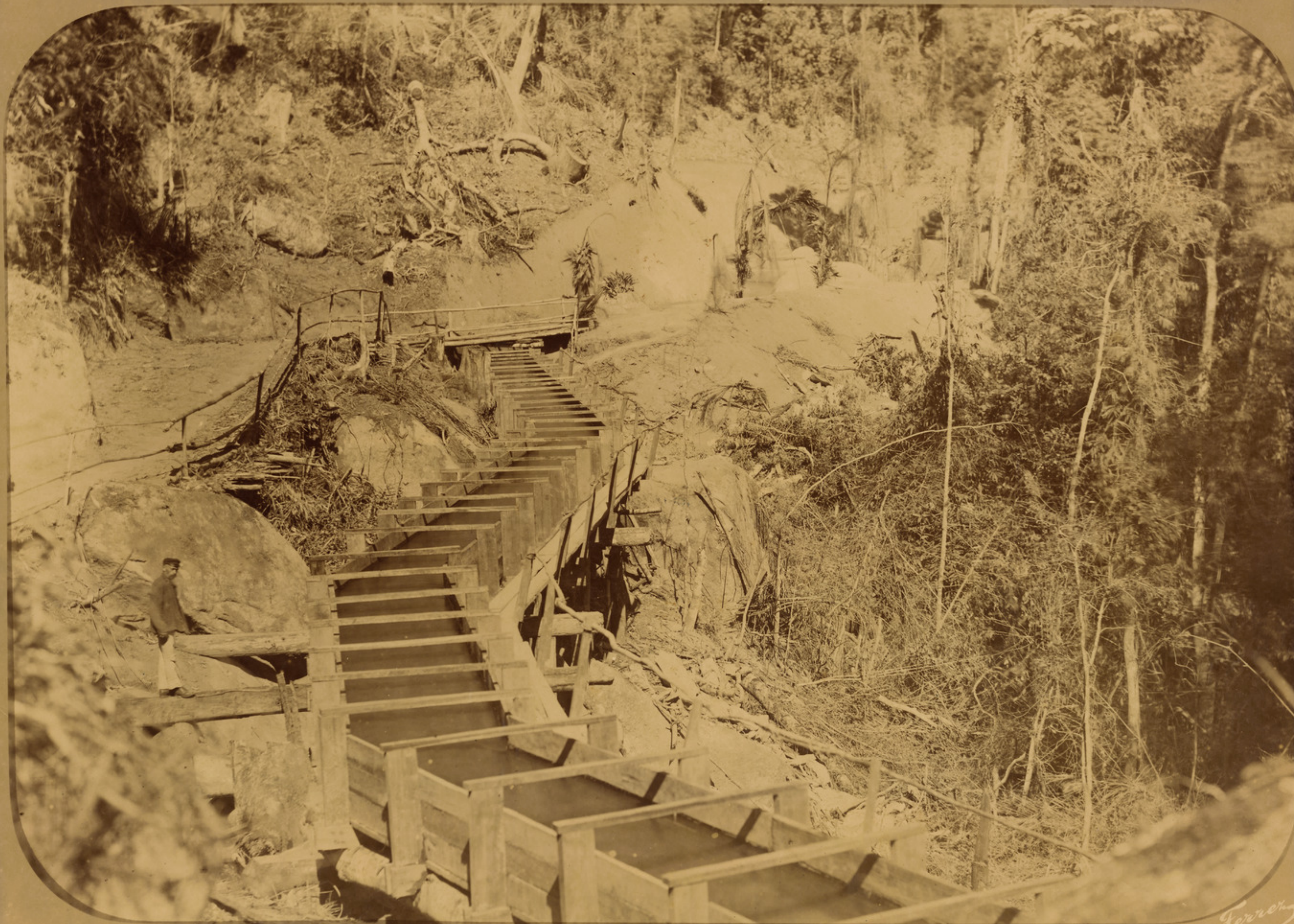
Aqueducto dos Immigrantes K. 6
