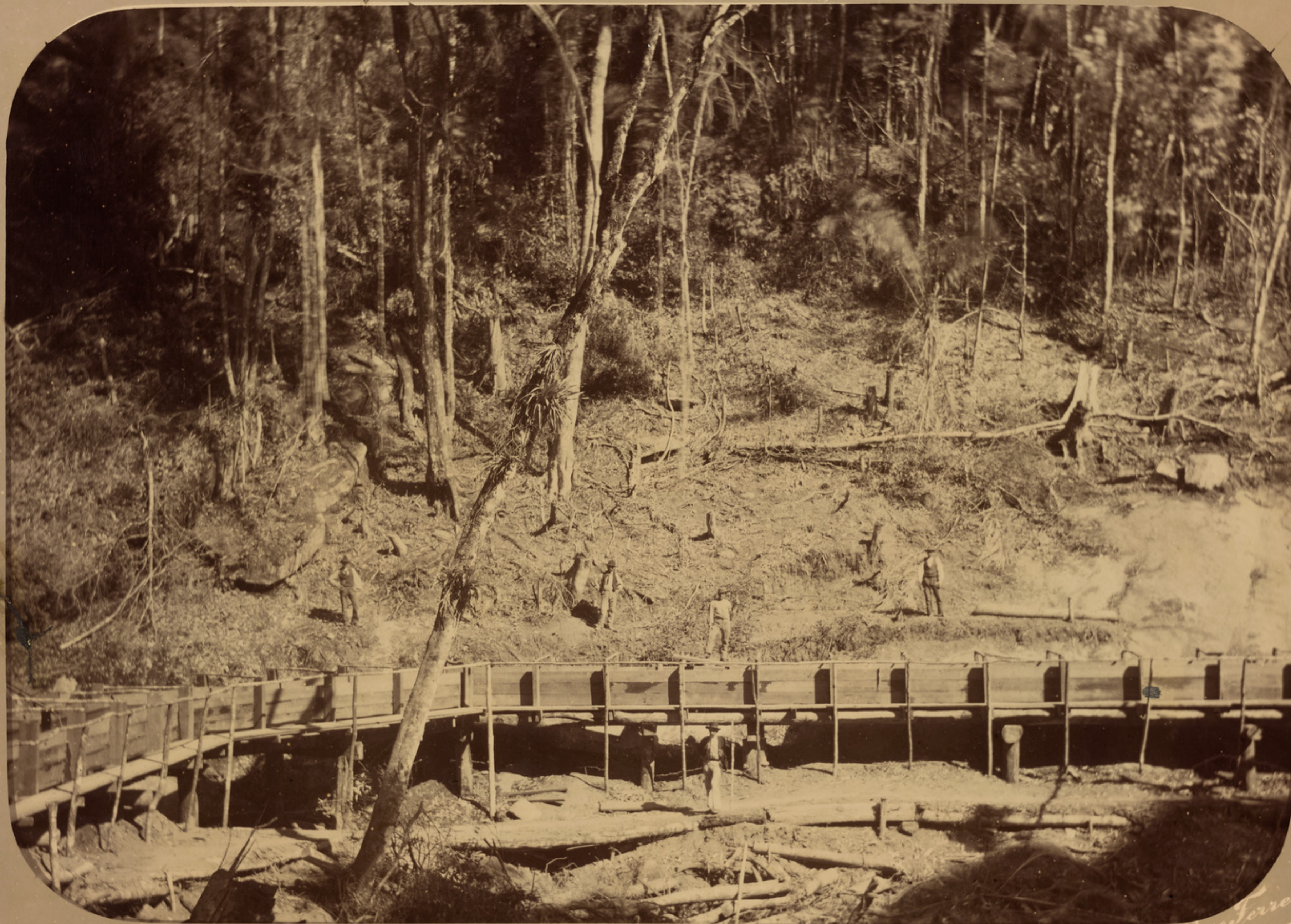
Aqueducto da Ferraria K. 7
