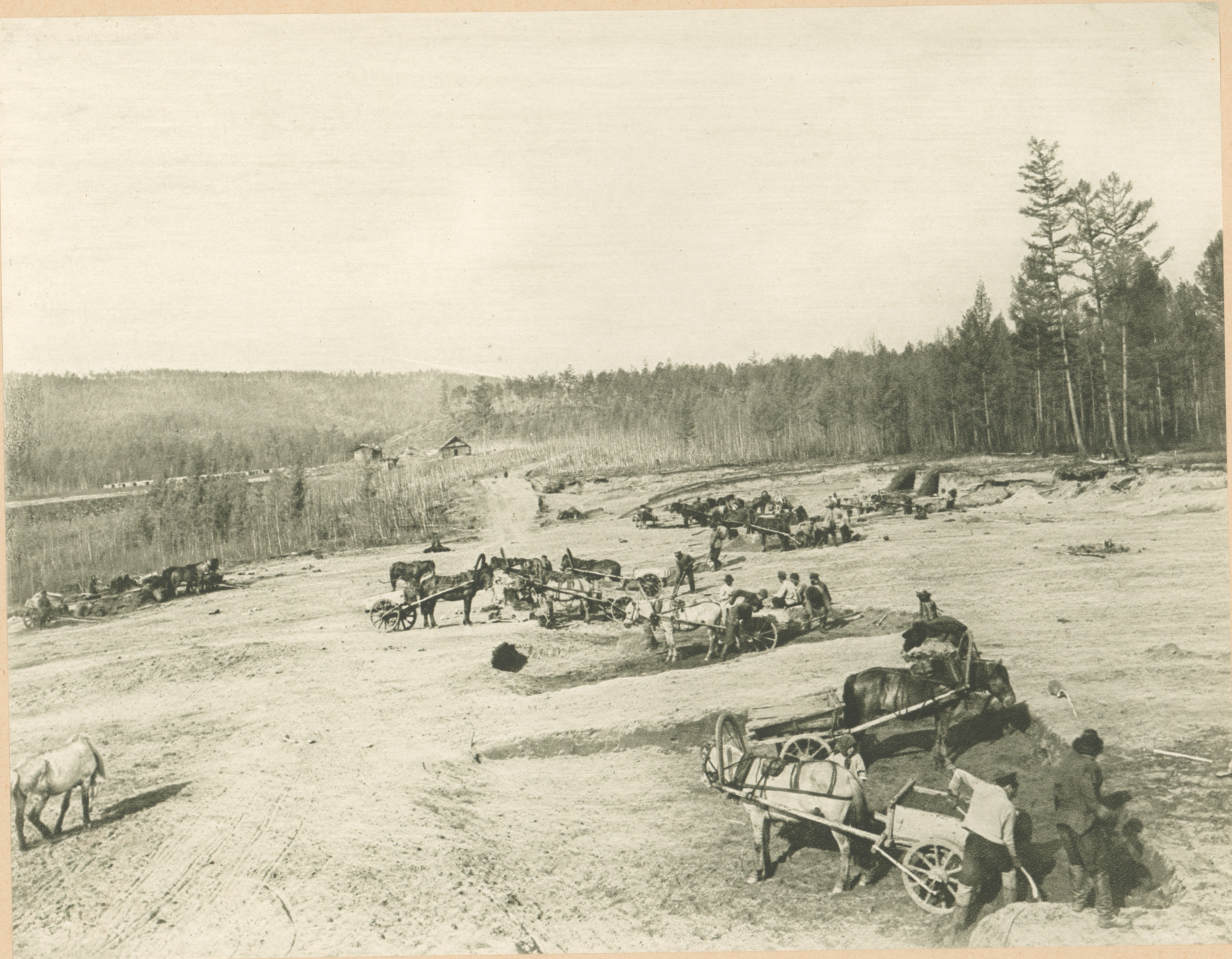
ЗЕМЛЯНЫЯ РАБОТЫ НАСЫПИ ВЕРСТА 498-Я. РАВТЫ ВЪ КАРЬЕРѢ.
