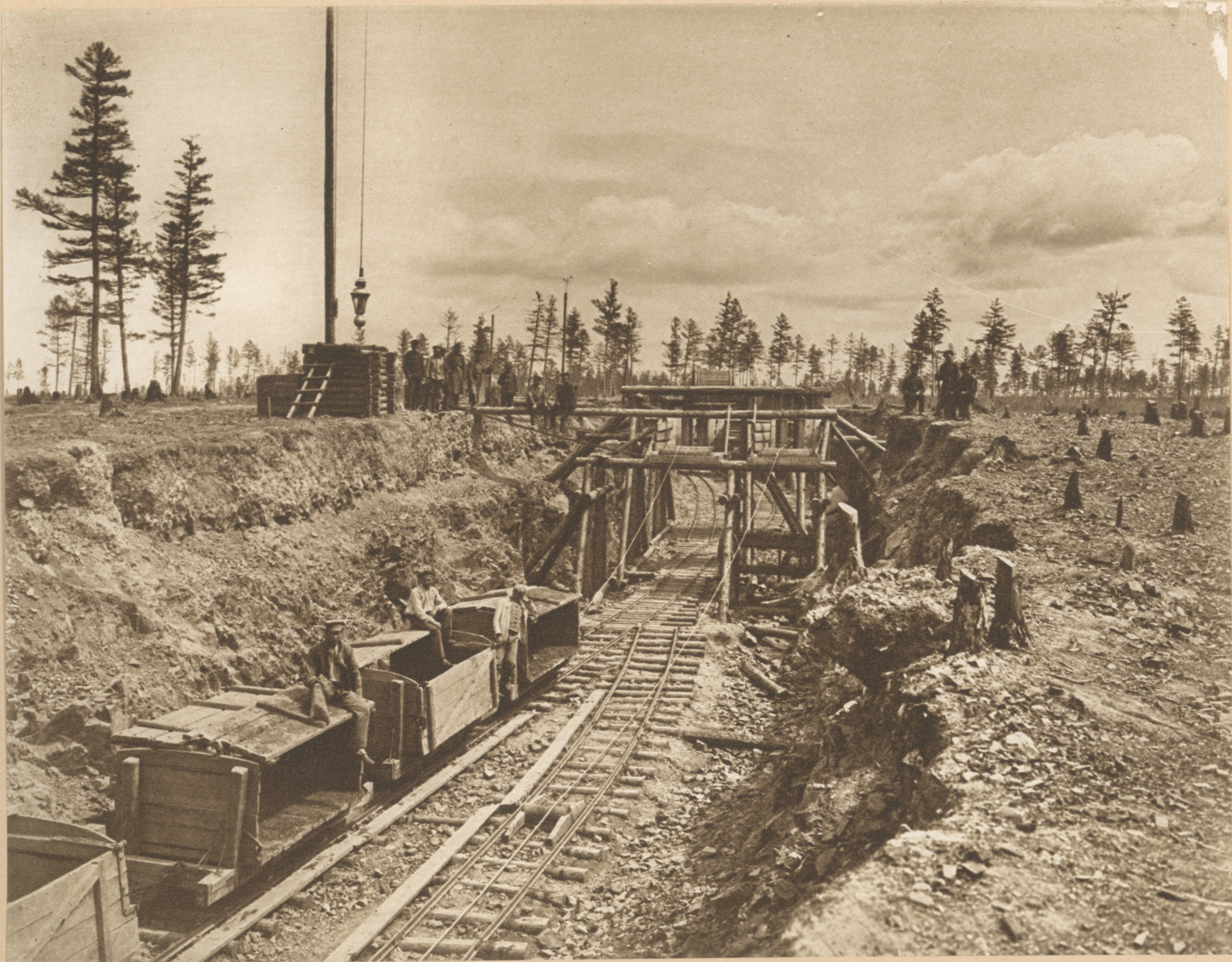
МЕХАНИЧЕСКОЕ ПРИСПОСОБЛЕНИЕ ПРИ ЗЕМЛЯНЫХ РАБОТАХ ВЕРСТЫ 515-Й ДЛЯ СПУСКА ПО УКЛОНУ ГРУЖЕНЫХЪ И ОБРАТНАГО ПОДЪЕМА ПУСТЫХЪ ВАГОНЕТОКЪ СЪ ПОМОЩЬЮ ПЕРЕВѢСА ТЯЖЕСТИ.
